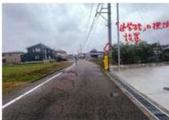
減速マークの路面標示の設置(市) 「通学路」の標識の設置(市)
