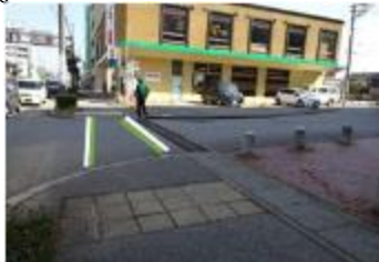
横断指導線の設置(内側に着色)(市)
