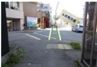
横断指導線の引き直し(内側に着色)(市)
