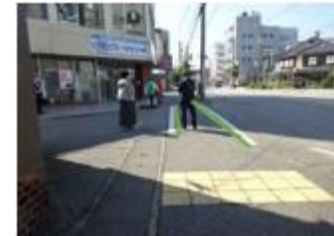
横断指導線の内側の着色(市) 「学童注意」の路面標示の設置(市) 停止指導線の設置(市)
