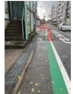
ラバーポールの設置(市)
