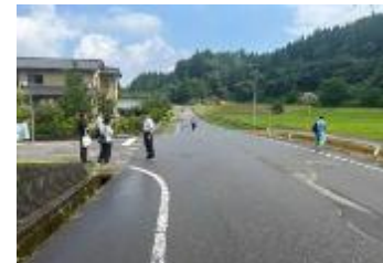
区画線の引き直し(県)
