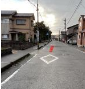
「速度落せ」の路面標示の設置(市)
