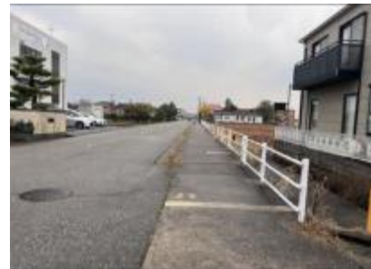
転落防止柵の更新(市)
