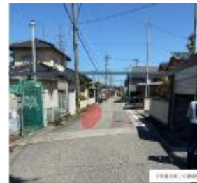
学童注意の路面標示の設置(市)
