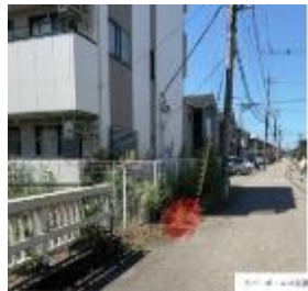
ラバーポールの設置(市)
