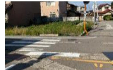
横断歩道の引き直し(中署) 外側線の引き直し(市)
