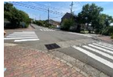
横断歩道の設置(中署) 横断歩道の引き直し(中署)
