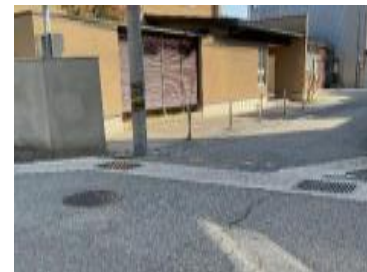
停止線の引き直し(中署) 外側線・クロスマークの引き直し(市)
