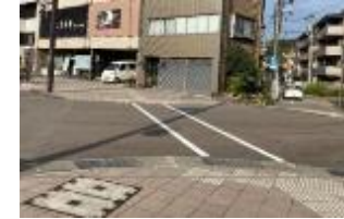
横断指導線の内側にグリーンベルトの設置(国)
