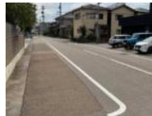
「速度落せ」の路面標示の設置(県)
