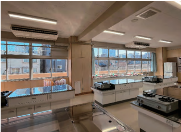
特別教室等への空調設備の整備
