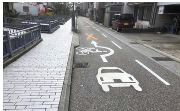
<補修後の路面表示（せせらぎ通り）>
